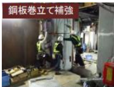
高架橋柱 (在来線)
