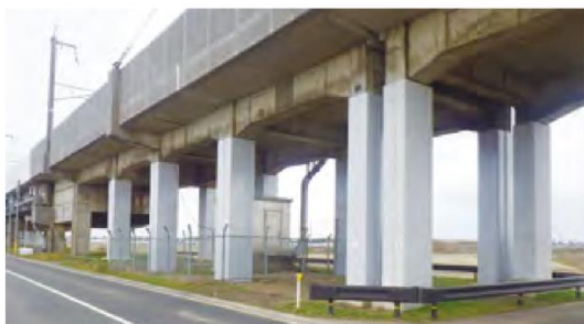
高架橋柱耐震補強
