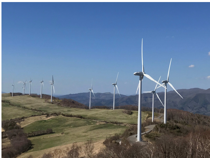
「くずまき第二風力発電所」(岩手県 44.6MW 2MW×16 基、2.1MW×6 基)
