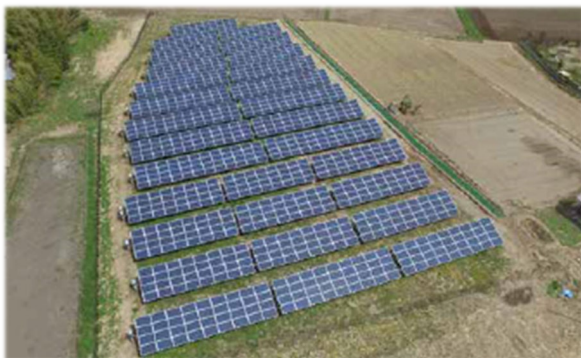
四郎丸自社発電所
