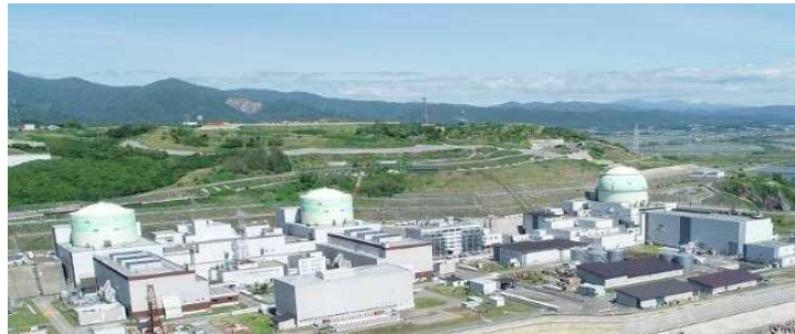
泊発電所 1 号機、2 号機及び 3 号機(北海道古宇郡泊村)
