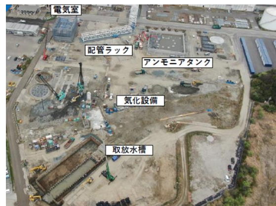
写真-2 プロジェクト① アンモニアタンクエリア工事状況 (2023 年 3 月時点)
