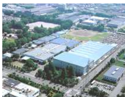
株式会社甲府明電舎
