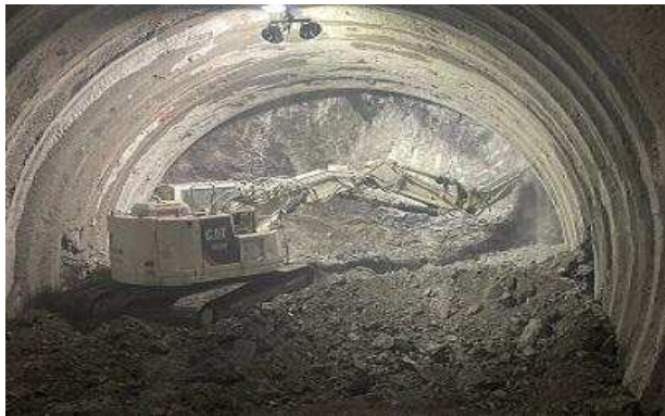
渡島トンネル（南鶉）（北斗市・厚沢部町） トンネル掘削状況
