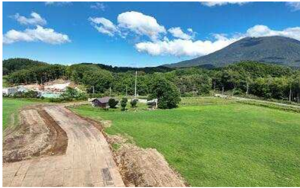
羊蹄トンネル（有島）（ニセコ町） 地上部
