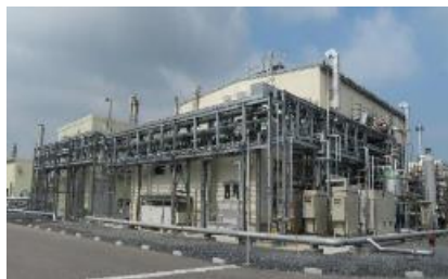
※小型実証設備 第1プラント
