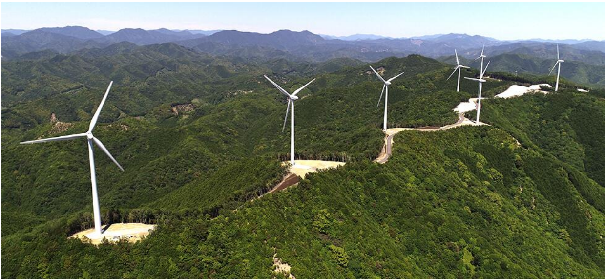
図-2 印南風力発電所
