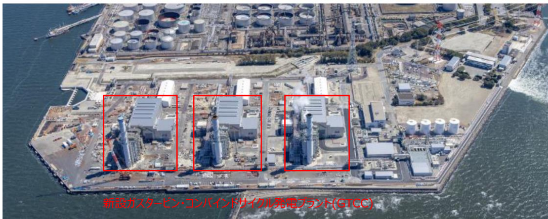
写真-3 五井火力発電所の撤去及び電源リプレイス工事
