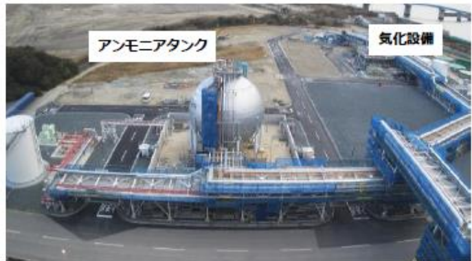
写真-2 プロジェクト① アンモニアタンクエリア工事状況 (2024 年 3 月時点)
