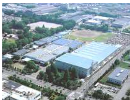
株式会社甲府明電舎
