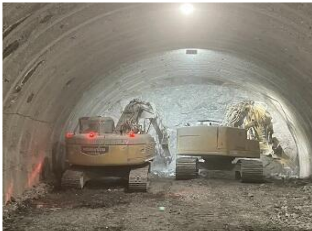
渡島トンネル(台場山)(北斗市) トンネル掘削状況
