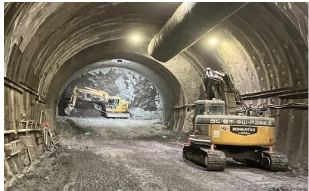
渡島トンネル（台場山）（北斗市） トンネル掘削状況
