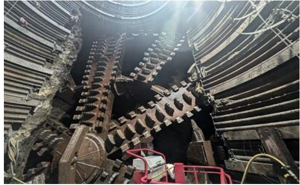
羊蹄トンネル（比羅夫）（ニセコ町・倶知安町） 中間立杭マシン面板
