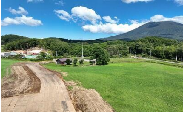
羊蹄トンネル（有島）（ニセコ町） 地上部
